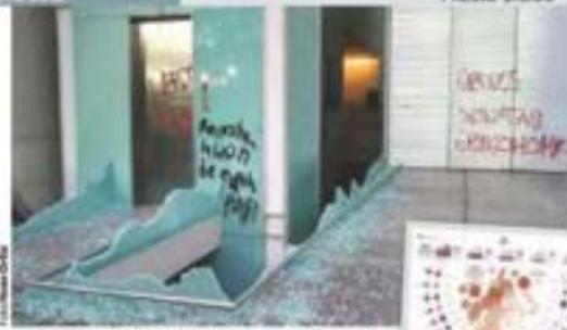
DAÑOS al MUAC, en Ciudad Universitaria, ayer.
