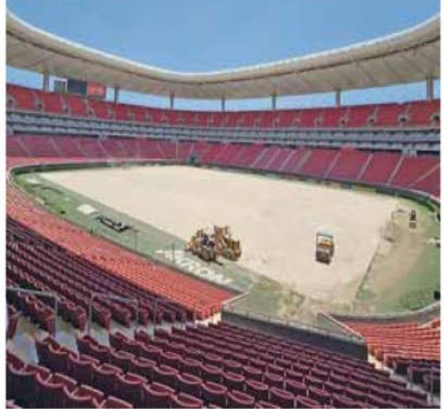
Estadio. Se espera que para el próximo 10 de julio se concluyan satisfactoriamente los trabajos y el cambio del nuevo césped híbrido. / GABRIELA ACOSTA
