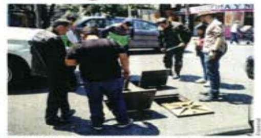
Además del análisis de la calidad de agua, se realiza desazolve del drenaje.
