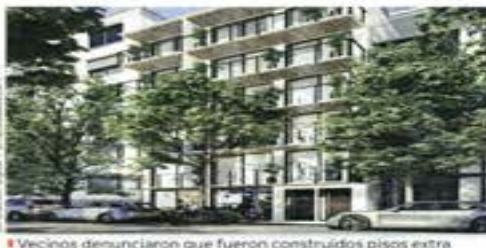
Vecinos denunciaron que fueron construidos pisos extra en Oaxaca 33 sin los permisos legales.
