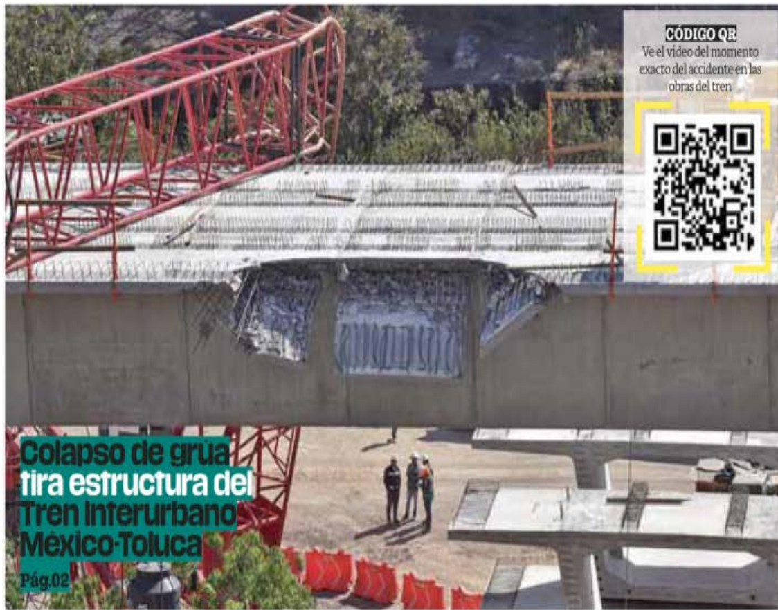
CDMX. Una dovela de las obras del tren interurbano cayó sobre dos vehículos después de que una grúa colapsara, en la zona de Observatorio. / CUARTOSURCO
