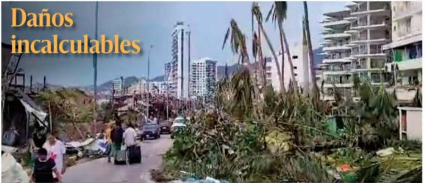
Palmeras, autos, ventanales, anuncios espectaculares, techos y palapas de la costera Miguel Alemán no soportaron los vientos y ráfagas con las que impactó el huracán Otis los primeros minutos de ayer miércoles.
