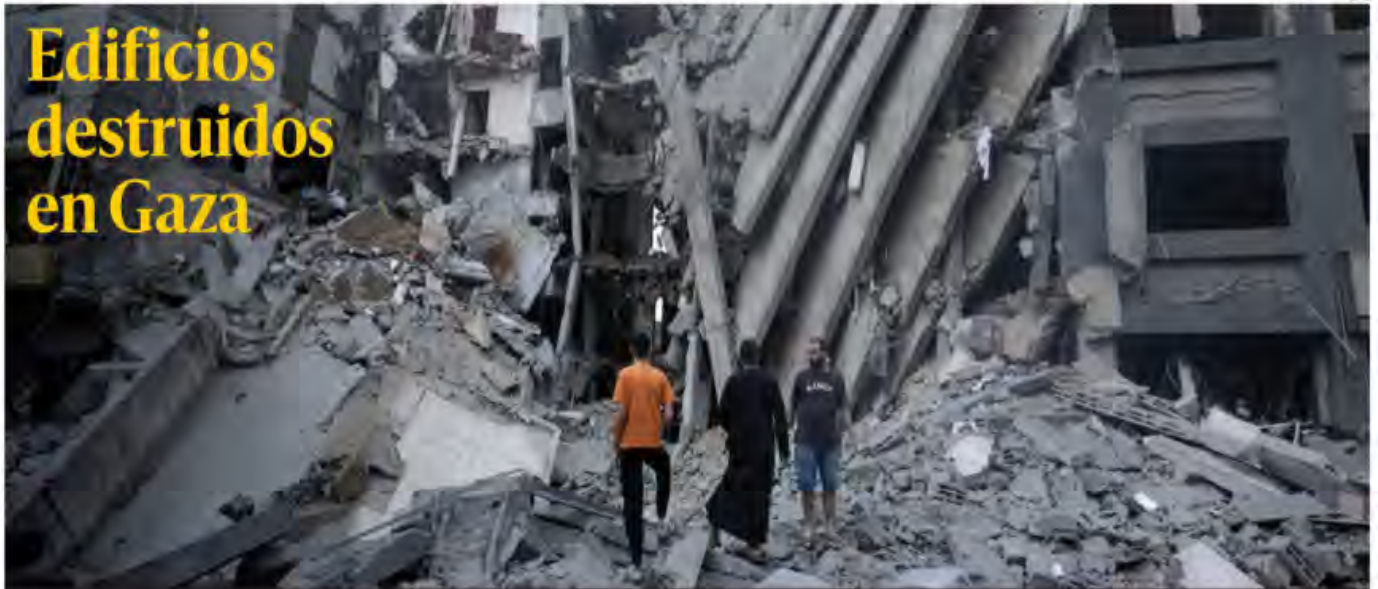
Palestinos observan el edificio destruido del Banco Nacional tras los ataques aéreos israelíes, en la ciudad de Gaza la madrugada del domingo. Los bombardeos israelíes han matado a más de 300 personas en la Franja de Gaza, dijeron fuentes oficiales palestinas.
