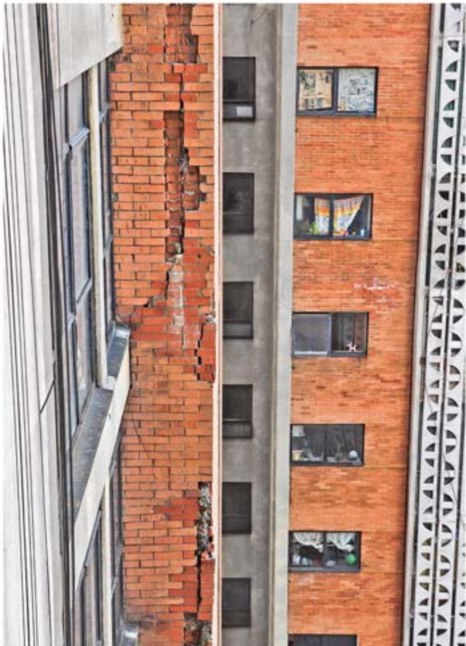
VIVEN EN RIESGO. En los Soldominios, de la colonia Doctores, no llega la ayuda para su reconstrucción, a pesar de las grietas, hundimientos e inclinación de los multifamiliares. Hoy, el Segundo Simulacro Nacional CDMX P. 7 Y 8
