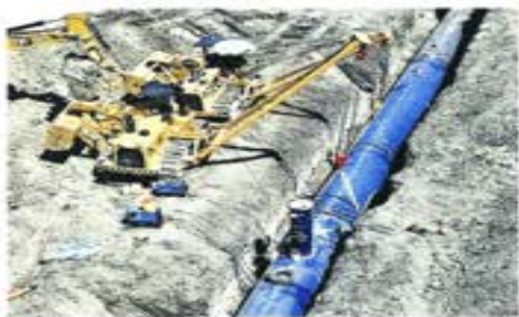
Un segmento del ducto, atrás de la Refinería de Cadereyta, es sostenido por dos grúas para apenas ser unido ayer.
