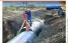
A 4 días del "inaugurado", el acueducto sigue en obras.
