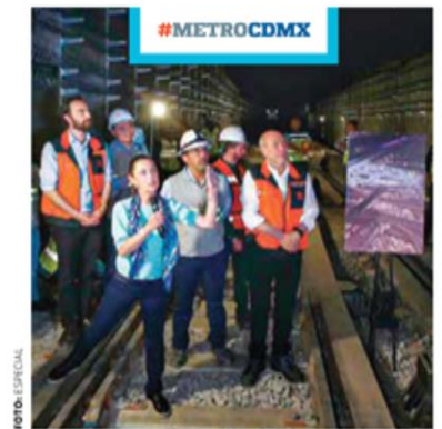
Tramo de L1 renovado, listo para mayo P14
